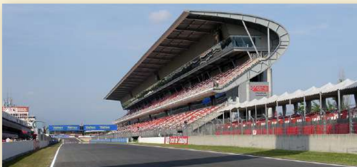
Figura 3.20 La tribuna junto a una recta del circuito de carreras del Circuito de Barcelona-Cataluña, ubicada donde los espectadores no corren peligro.
