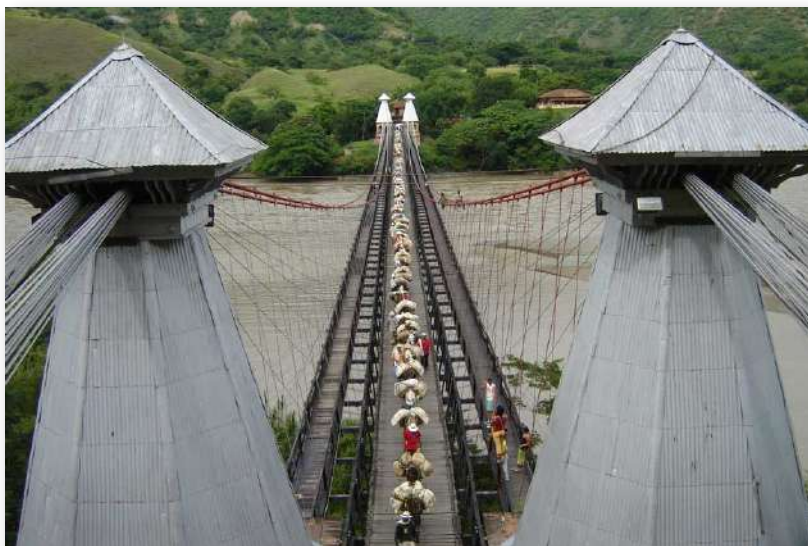
Figura 7.2. Puente de Occidente. Santa Fe de Antioquia
