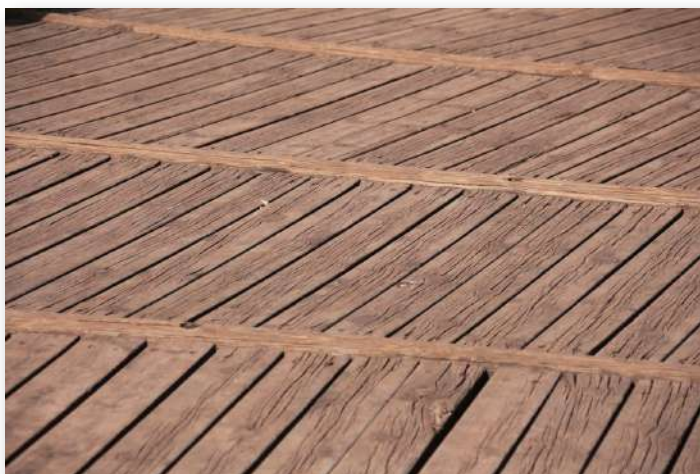
Figura 7.5. Deterioro de la madera al ambiente. Imagen de Christine Schmidt en Pixabay .
