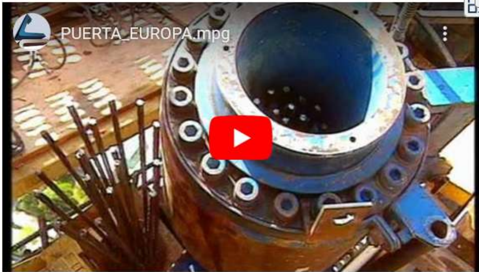
Vídeo 5.2. Construcción de las Torres Puerta de Europa de Madrid.
